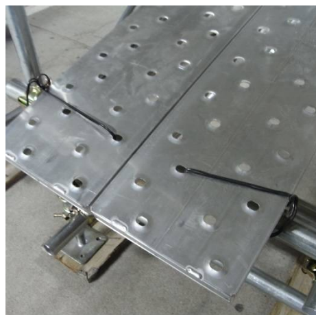
足場板の固定
