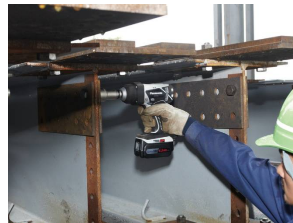
H形鋼スプライスプレートの締め結
