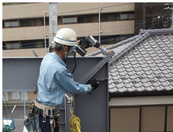
建て方工事の仮締め
