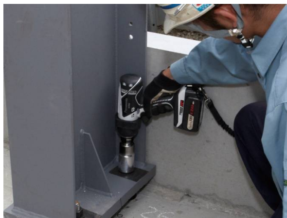
アンカーボルトの締め付け
