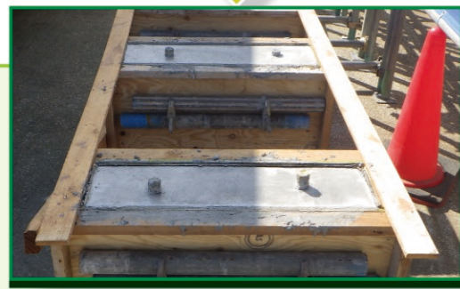
2 生コンクリートを流し込み、保水、保温などをして固まるのを待つ
