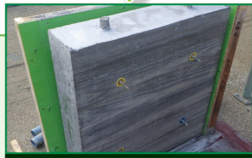
3 固まったら型枠を取り外す
